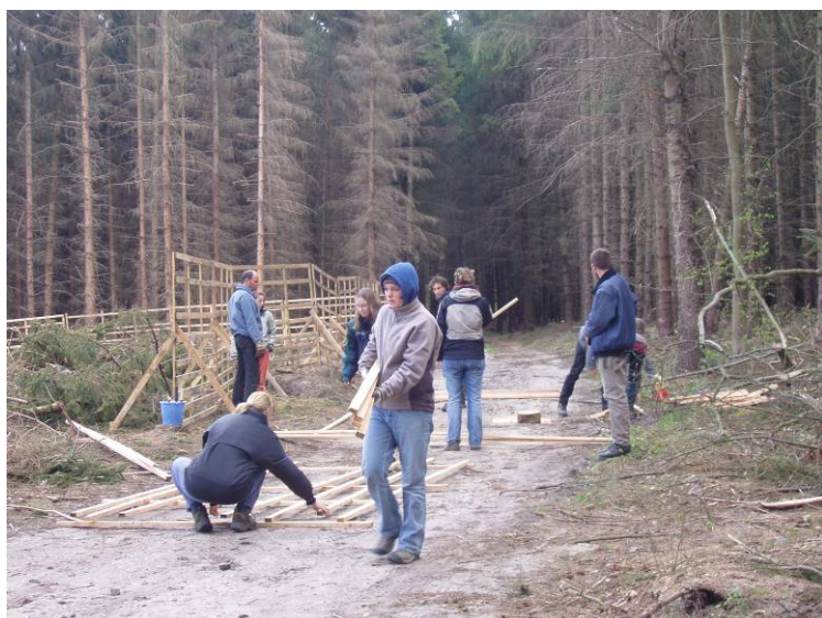
Abb. 2: Gatterfelder werden zusammengebaut
